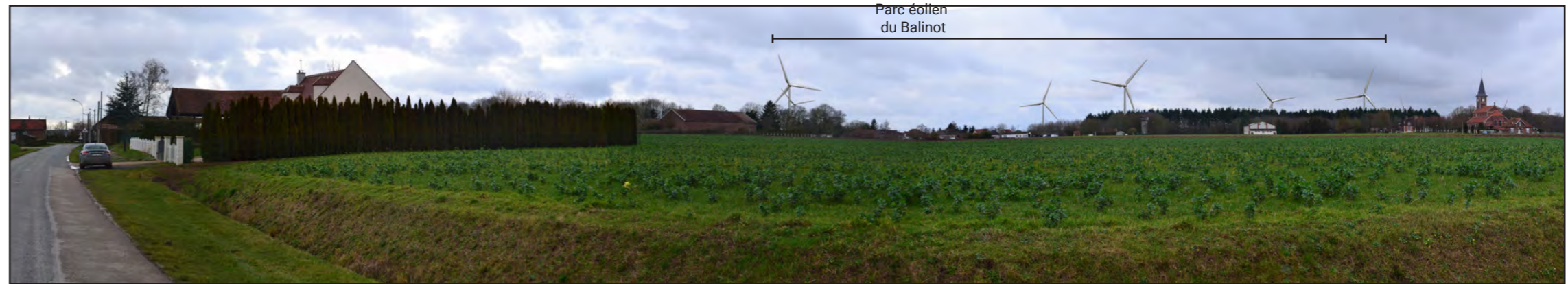
État initial - Vue panoramique
